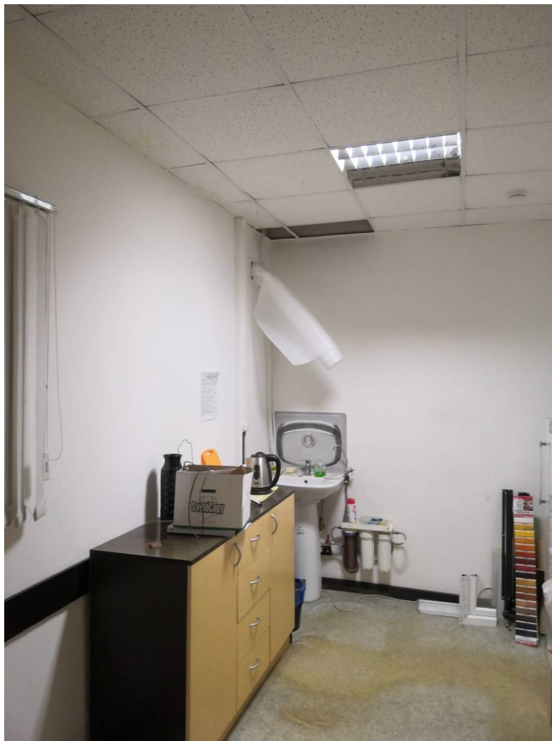
Рисунок 2. Помещение низкого давления.
